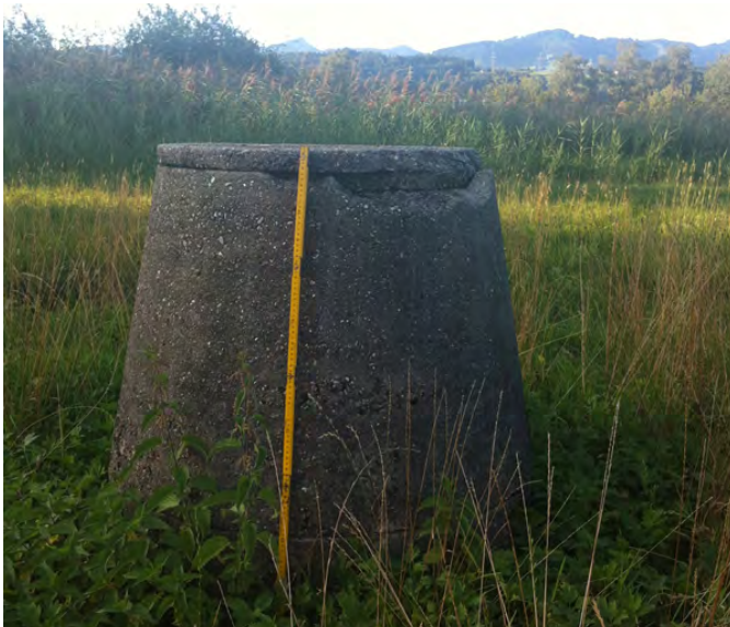
Abb. 7: Schacht in der südlichen Pufferzone des Entensees, der aufgrund von Bodensackungen als Folge der Entwässerung heute rund 1m aus dem Boden ragt.
