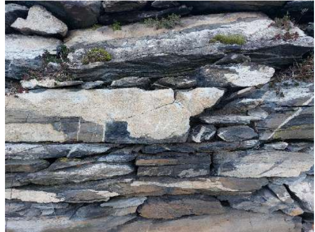
Abbildung 3: Unterschiedliche Steine und Mauerbilder der intakten Mauerabschnitte (kein Sanierungsbedarf)
