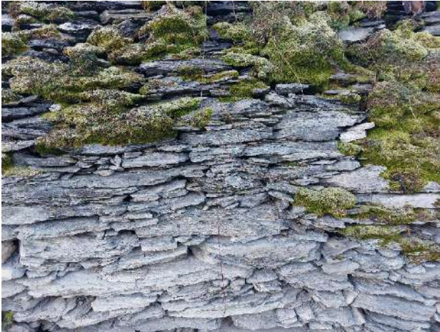
Abbildung 3: Unterschiedliche Steine und Mauerbilder der intakten Mauerabschnitte (kein Sanierungsbedarf)
