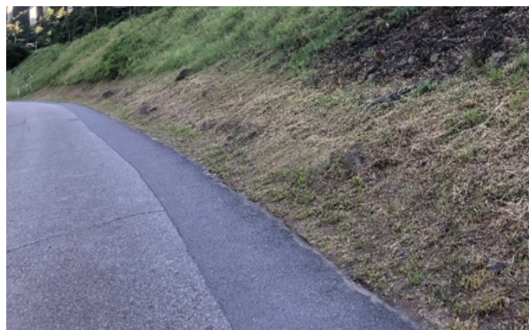
Area verde stradale priva di strutture, sfalciata a filo del suolo (Oikos Sagl)
