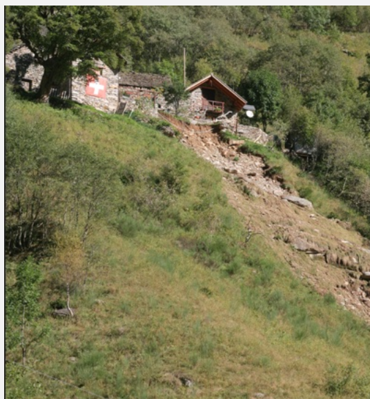
Fenomeni di erosione (A. Persico)
